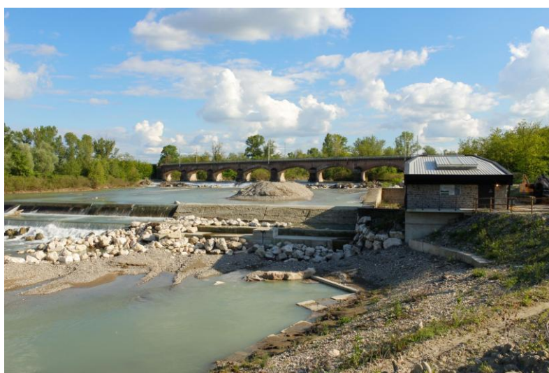
centralina idroelettrica "Il Moro"
