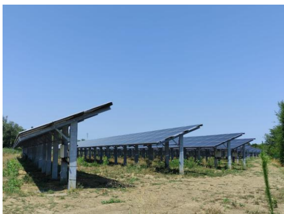
impianto agrivoltaico in corso di realizzazione
