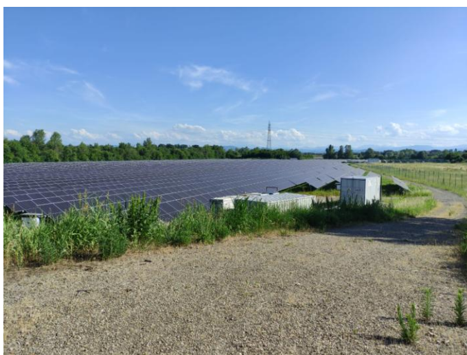
impianto fotovoltaico Partitore 1
