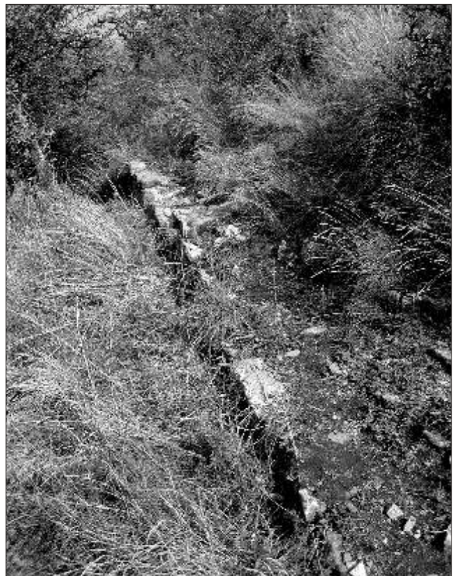
particolare di una cortina muraria
