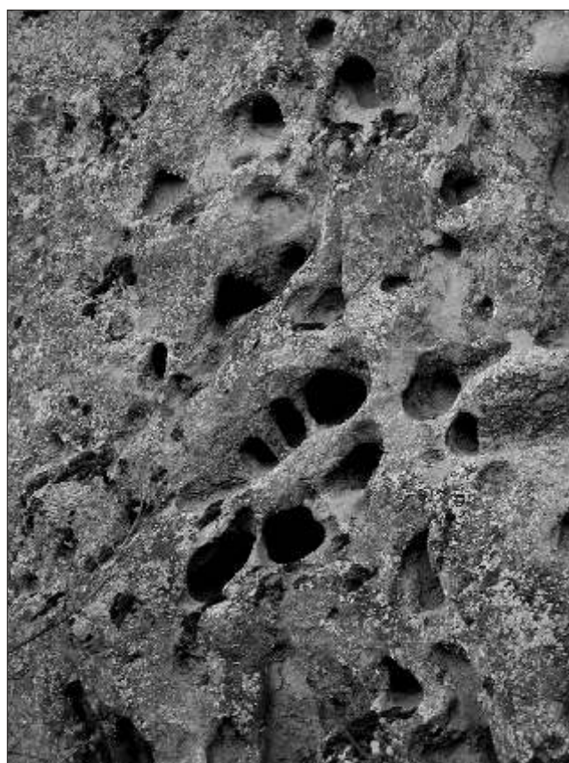
cavità di erosione nell'arenaria della rupe di Canossa
