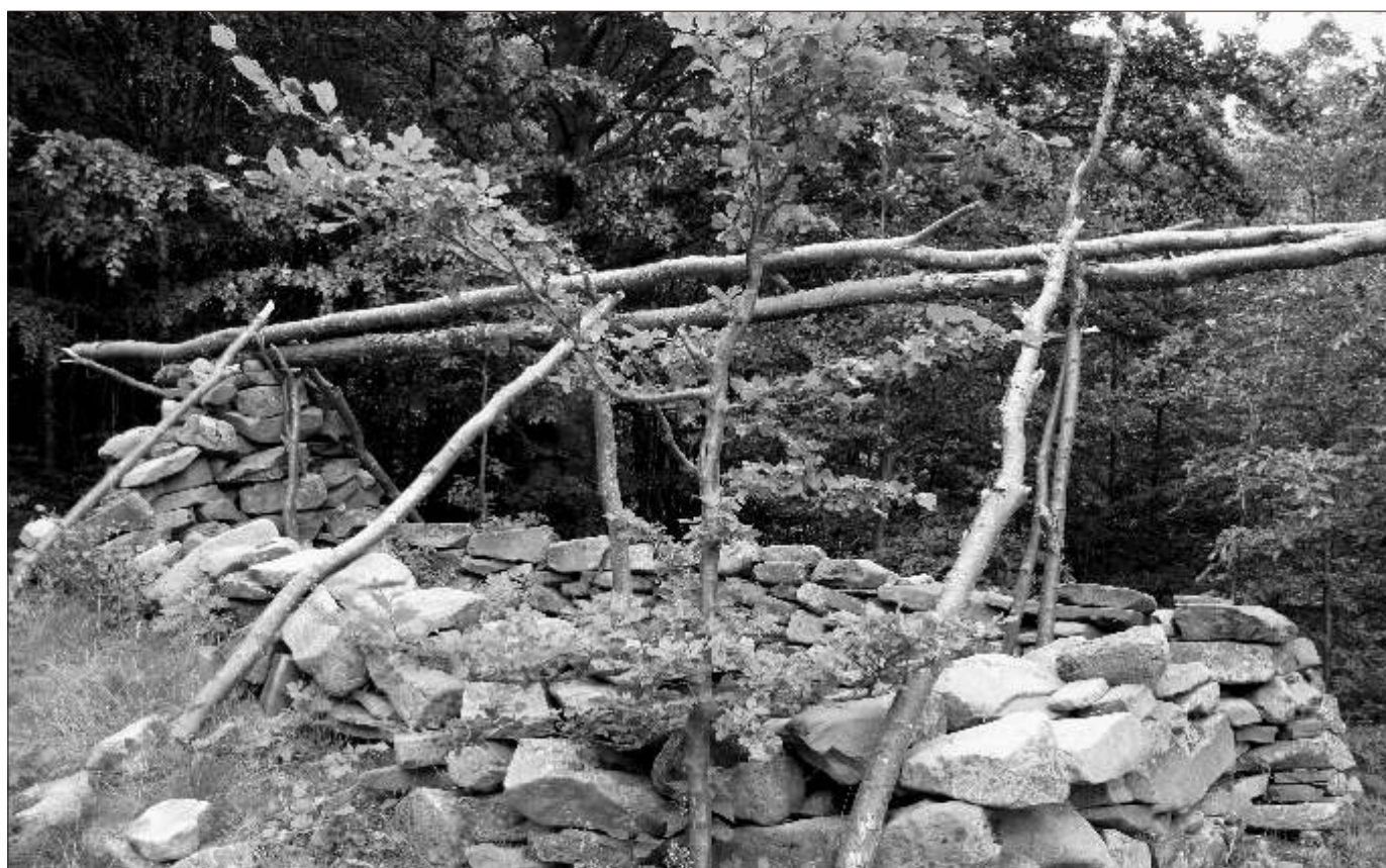
struttura di una caratteristica capanna pastorale con basamento in pietra a secco e copertura in ramaglia di faggio
