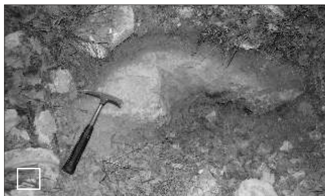
3 - 4: particolari della muratura a calce all'interno della cisterna
