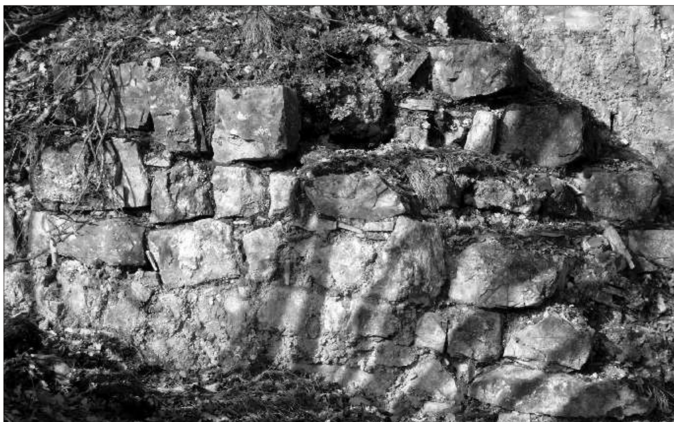
dettaglio della muratura: si noti la tecnica costruttiva in corsi paralleli tipicamente medievale
