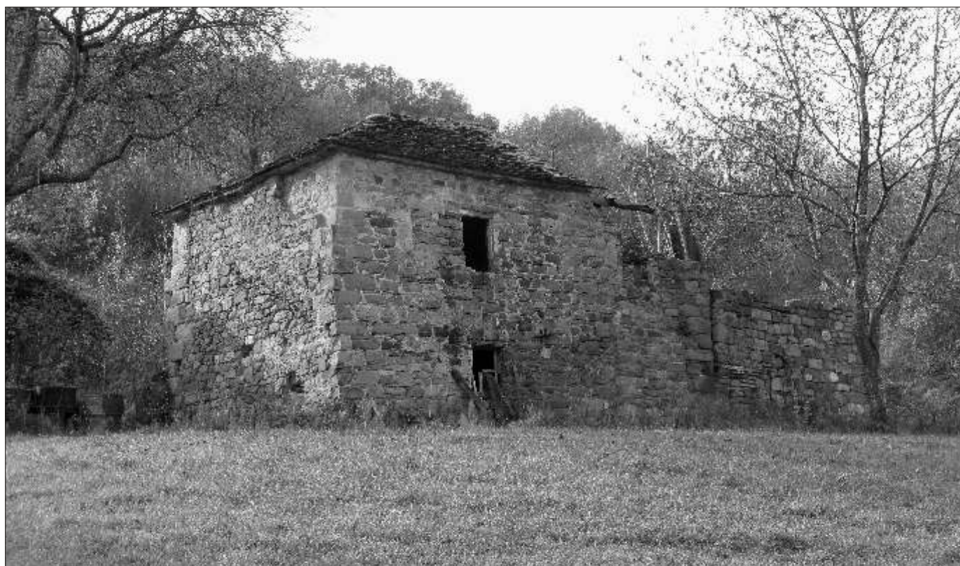
edificio in pietra, situato nell'area di Nasseta, che mostra il tradizionale manto di copertura in lastre di pietra
