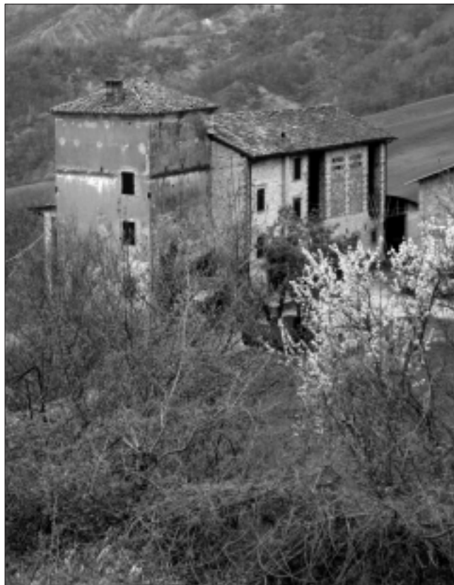
veduta della casa a torre
