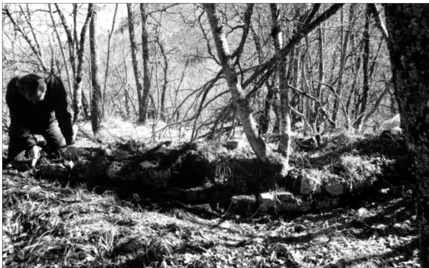
particolare delle strutture murarie
