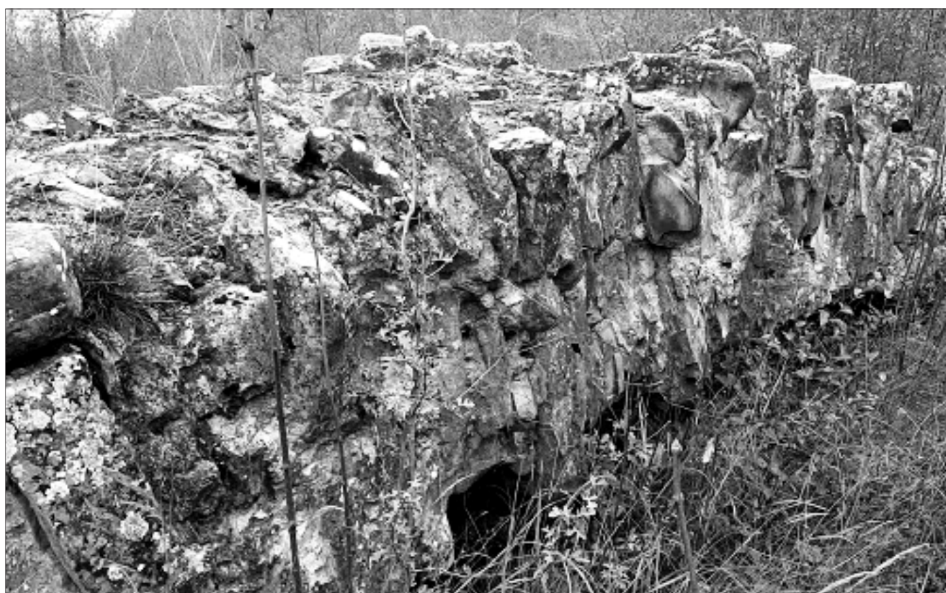
dettaglio della struttura muraria
